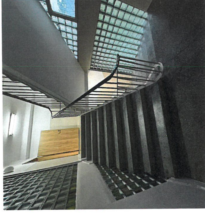
Remont klatki schodowej w PPP
