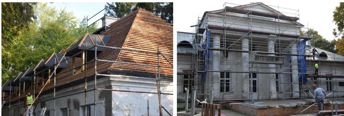
Przeprowadzenie prac remontowo-konserwatorskich w zabytkowym zespole pałacowo-parkowym w Dębinkach
